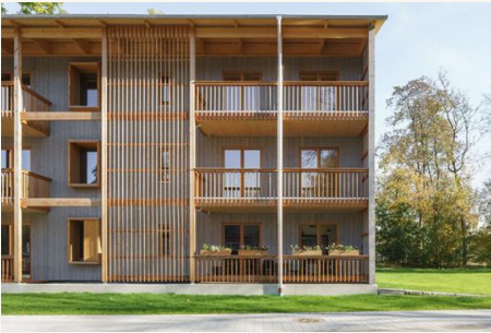
Balkons kunnen ontworpen worden als intermediaire zone.
