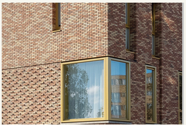
Oeverhoeks raam in combinatie met metselwerkdetails.
