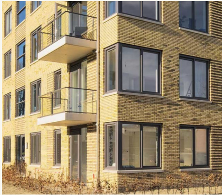
Zorgvuldige detaillering van de gevel.
