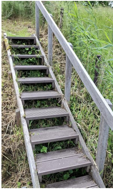
een vergelijkbare trap, welke is vervangen door een nieuwe trap
